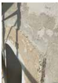
Intonaci degradati
