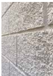
Elementi decorativi di facciata
