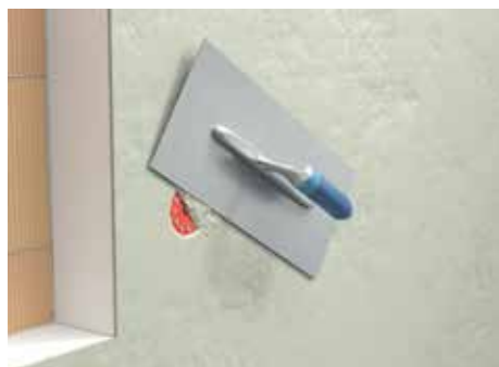
Livellatura dello strato di armatura
