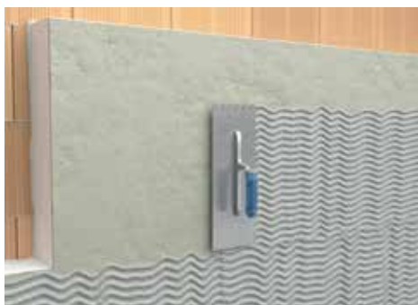
Stesura del collante CeramicFix sul supporto
