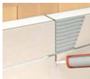
Sigillatura delle fughe
