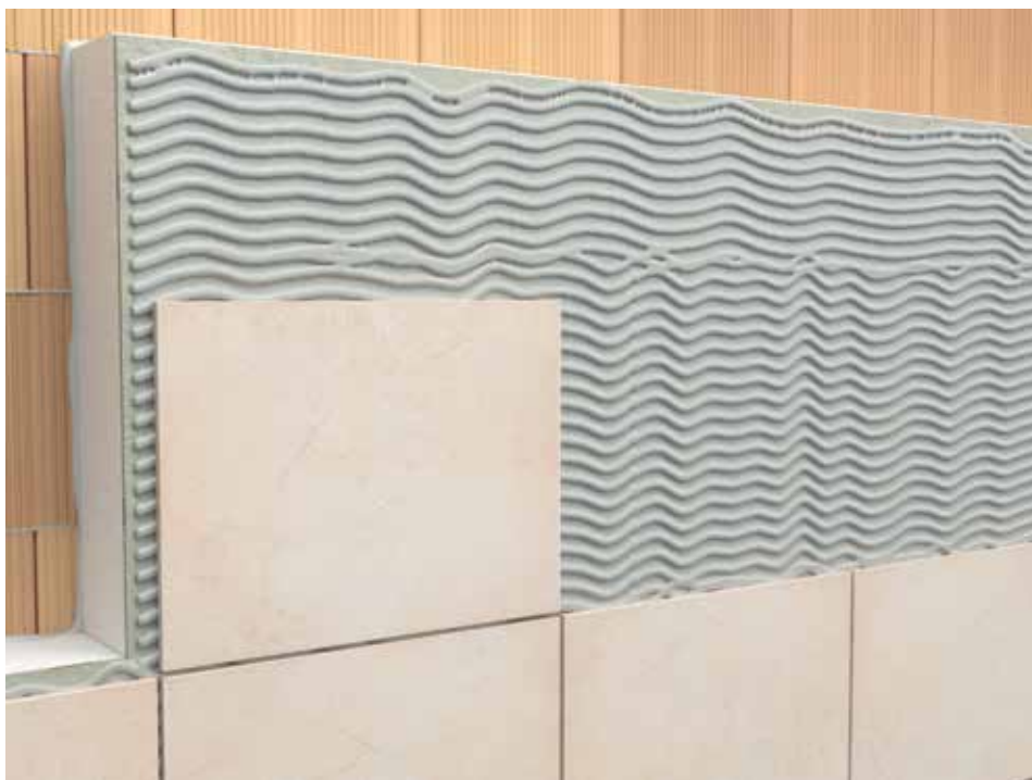
Posa fresco su fresco del rivestimento
