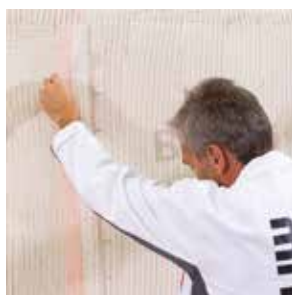
Posa della rete portaintonaco
