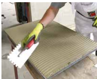
Incollaggio con Baunit CeramicFix - Metodo buttering-floating
