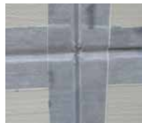
Esecuzione con banda sigillante
