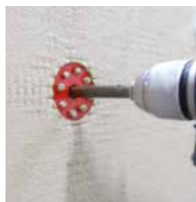
Tassellatura con tassello a vite Baumit SchraubDübel
