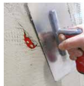
Rasatura delle teste dei tasselli
