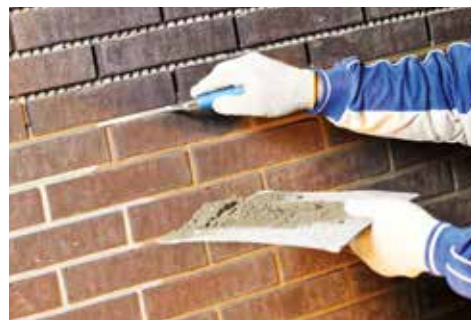
Sigillatura mediante ferro per fughe
