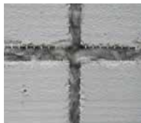
Riempimento con materiale isolante
