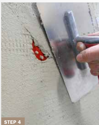
STEP 4 Seconda mano di rasatura fresco su fresco con copertura delle teste dei tasselli
