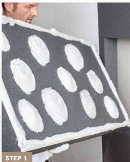
STEP 1 Incollaggio delle lastre Baunit EPS
