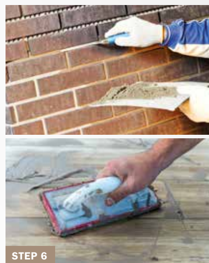
STEP 6 Stuccatura con Baunit Ceramic F o Ceramic S
