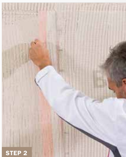
STEP 2 Prima mano di rasatura e allettamento della rete di rinforzo Baunit CeramicTex
