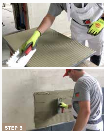
STEP 5 Incollaggio del rivestimento con il metodo del buttering-floating
