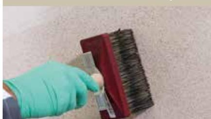
Il diverso assorbimento del supporto provoca delle sensibili variazioni di aspetto della pittura che si manifesta con macchie, efflorescenze o distacco della stessa.
