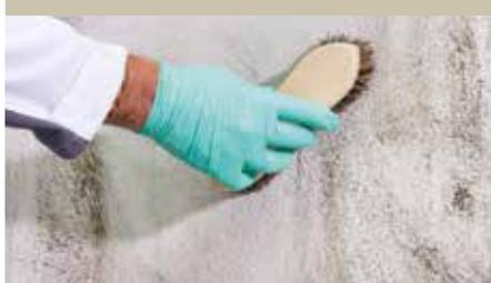
I depositi di sporco sulla superficie causano una scarsa adesione del rivestimento di finitura al supporto preesistente.
