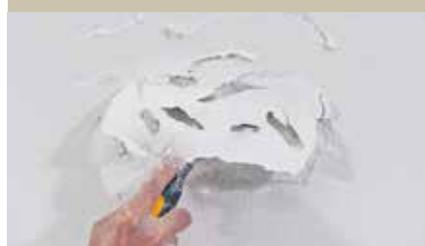
Prima di effettuare la tinteggiatura bisogna rimuovere eventuale materiale scrostato o degradato e provvedere ad appianare le irregolarità della superficie.
