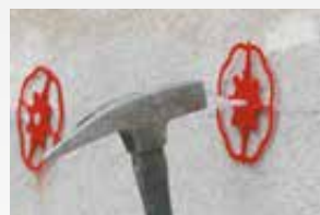
Gli ancoraggi adesivi di Baumit vengono inseriti nel foro e i tasselli di plastica vengono ribattuti all'interno.
